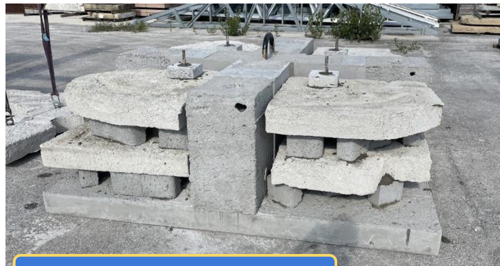
Assemblage en cours....
