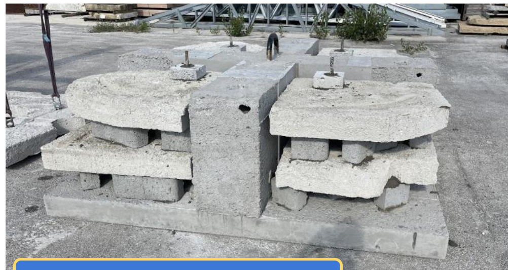
Assemblage en cours....
